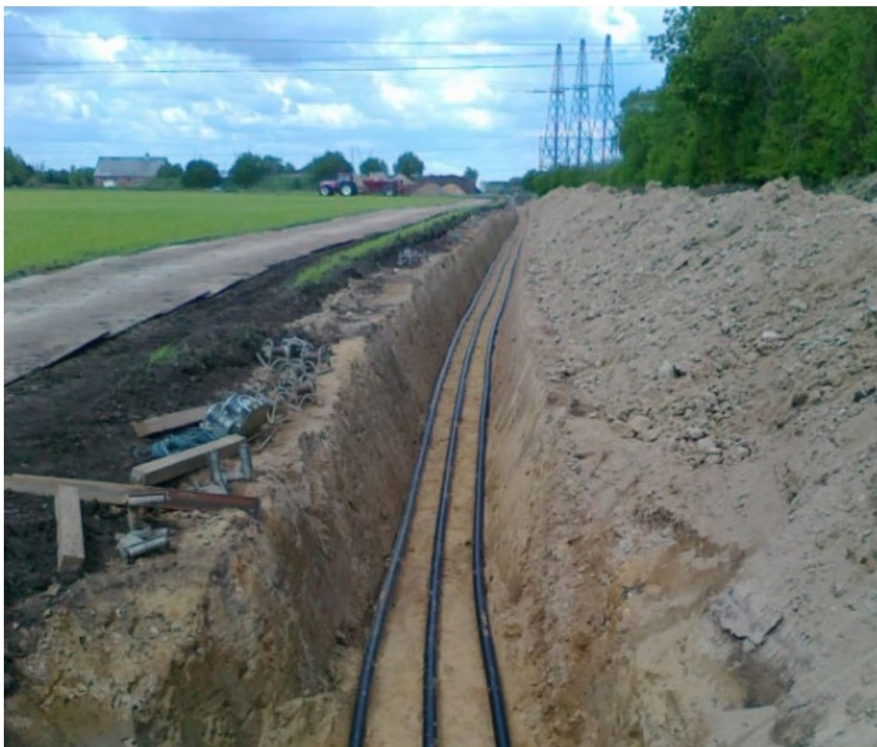
Figur 2-4 Kabelanlæg lagt ud i åben grav
