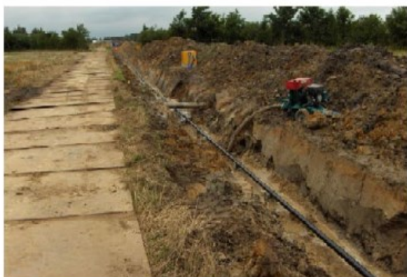
Figur 2-5 Forskellige metoder til at holde kabelgraven tør. På billedet til venstre etableres drænrør, til højre etableres sugespidsanlæg
