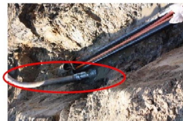
Kabelgraven pumpes med grundvandspumper
