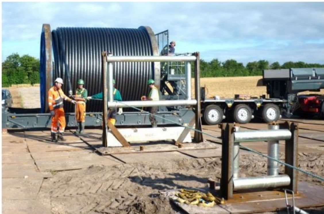
Figur 2-9 Kabeltromle på blokvogn
