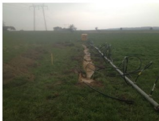
Figur 2-5 Forskellige metoder til at holde kabelgraven tør. På billedet til venstre etableres drænrør, til højre etableres sugespidsanlæg
