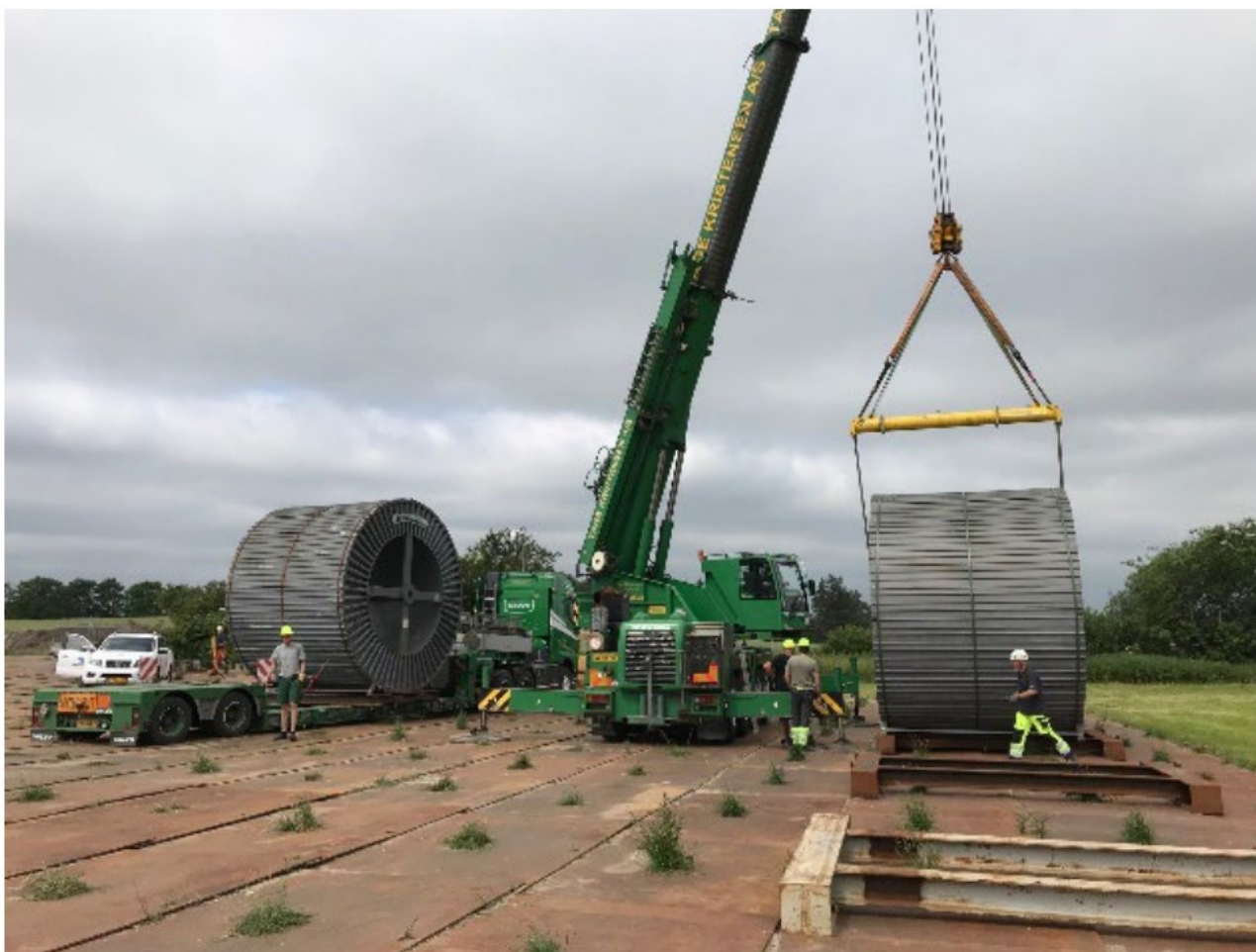
Figur 2-6 Håndtering af kabeltromler på tromleplads
